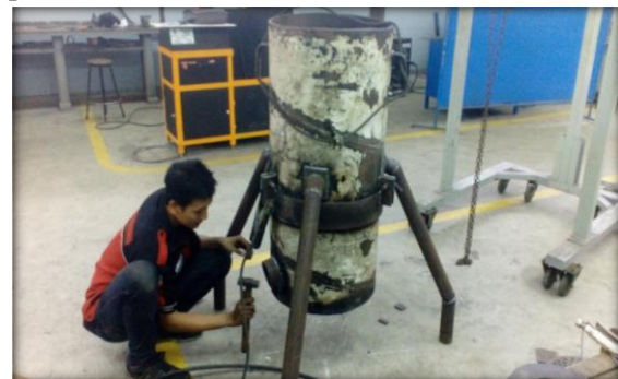
Gambar 3 : Pengelasan Pipa dan Rangka Furnace
